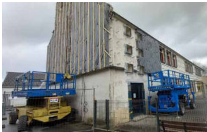
Rénovation en cours de l'école de Landeleau
