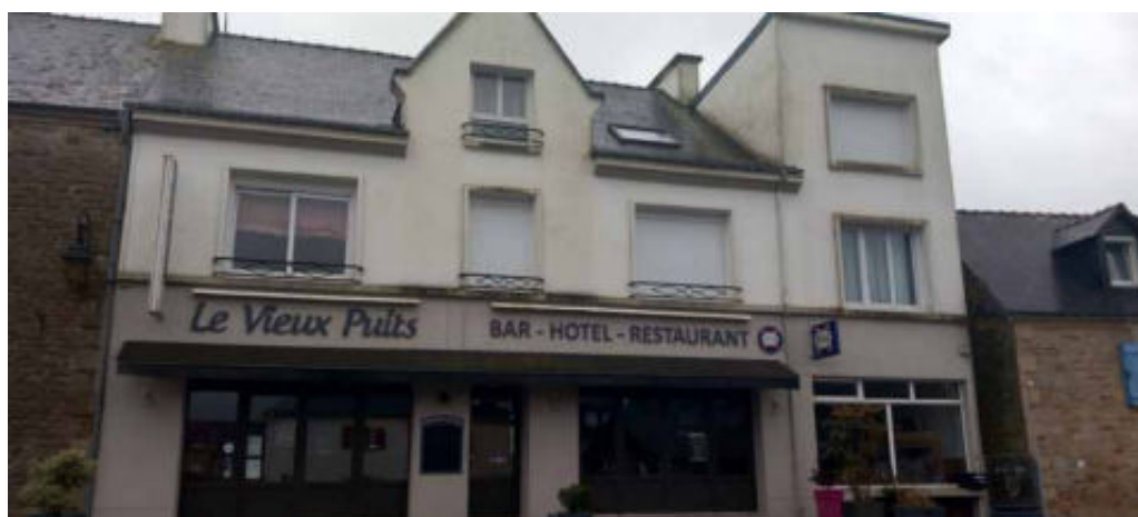
Auberge Le Vieux Puits à Meslan, équipée d'une chaudière bois granulés financée par le fonds chaleur
